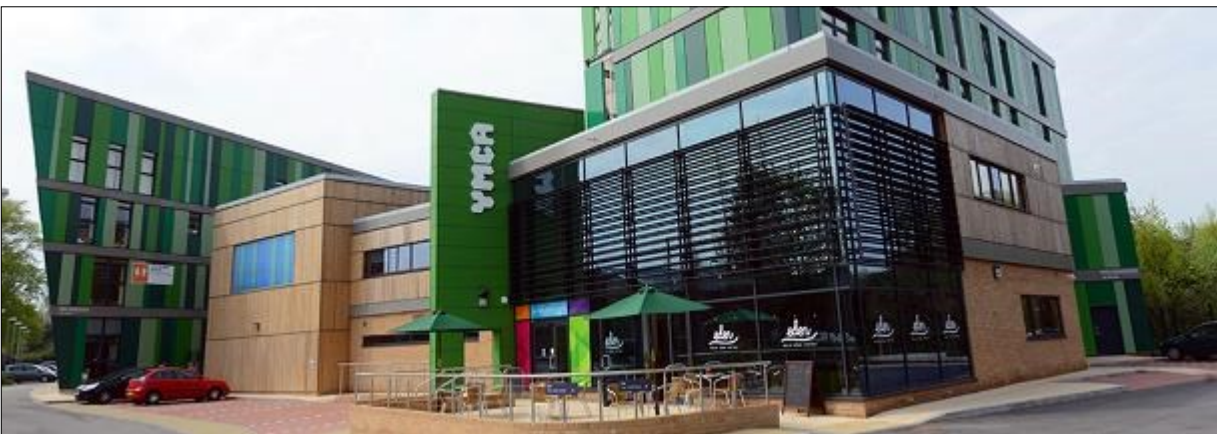
YMCA Birmingham Erdington site
